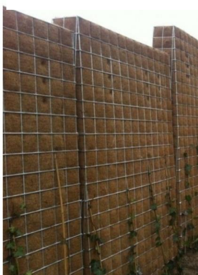
Figuur 30 Binnenwerk geluidabsorptie scherm
